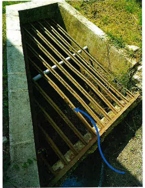
Vue du bac en béton et de la grille
