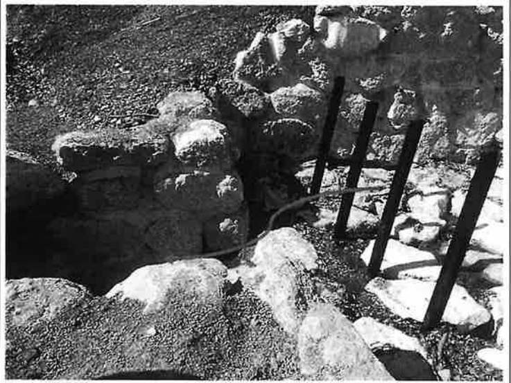
Vue des poutrelles filtrantes
