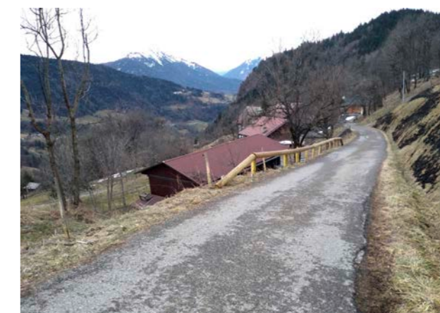
Barrières entre les Pezières et le Cernix
