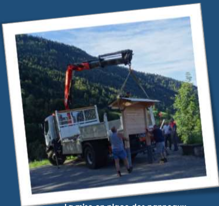
La mise en place des panneaux...
