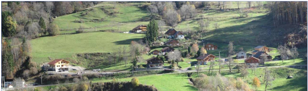
Photo 6 : La Longeret depuis la route du Cernix
