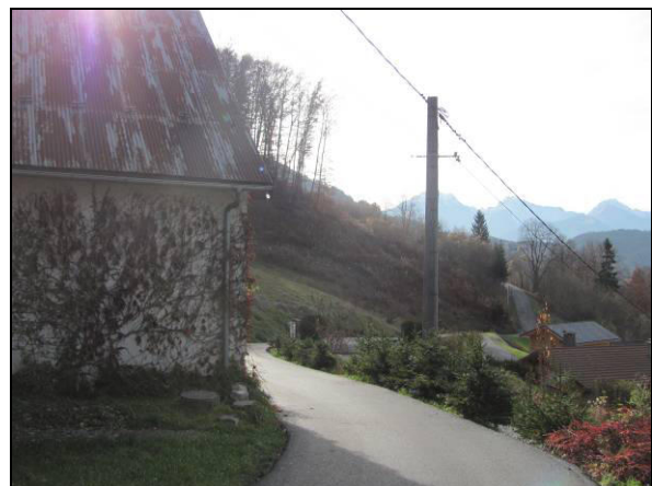
Photo 8 : Etranglement de la voie d'accès
